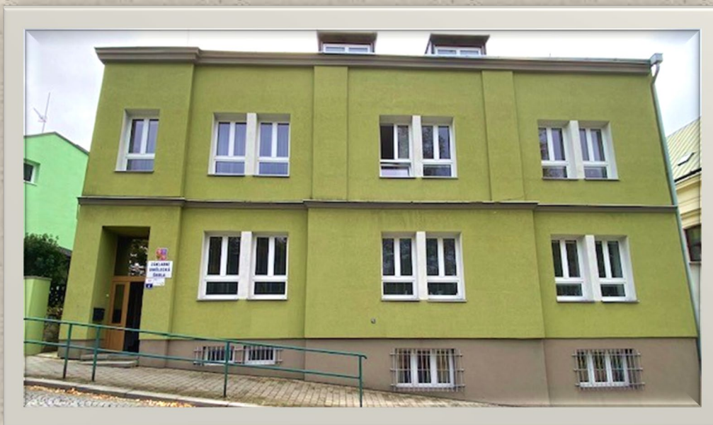
Hlavní budova na Keltičkově ulici 137/4
