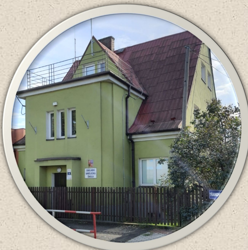
Budova v Radvanicích na ulici Třanovského 12
